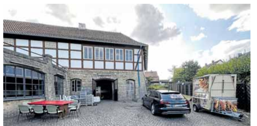
Auf dem Hof der Alten Schmiede laufen schon die Vorbereitungen.
